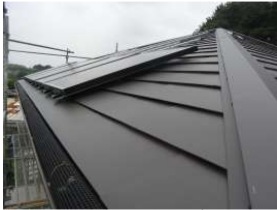
吹き替えた屋根と太陽光発電パネル、 落ち葉対策した雨樋
